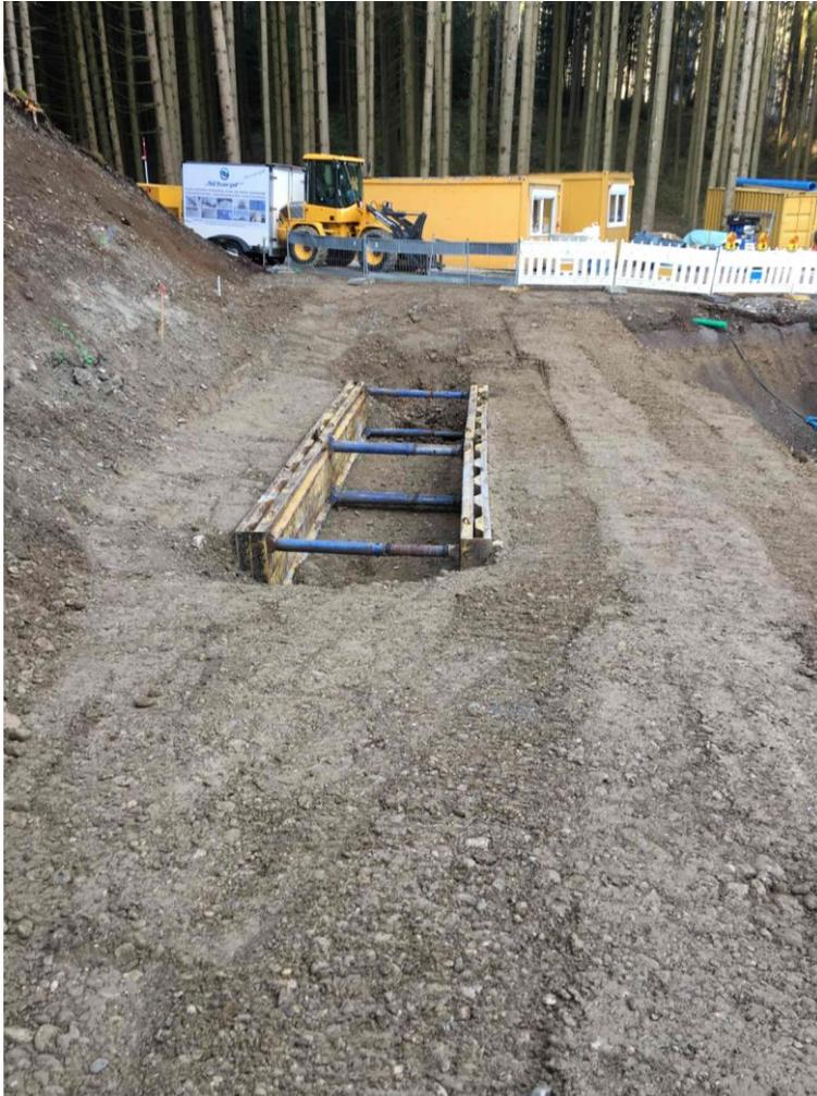
Dielenkammererelemente im Bereich Quelle 2 Zulauf
