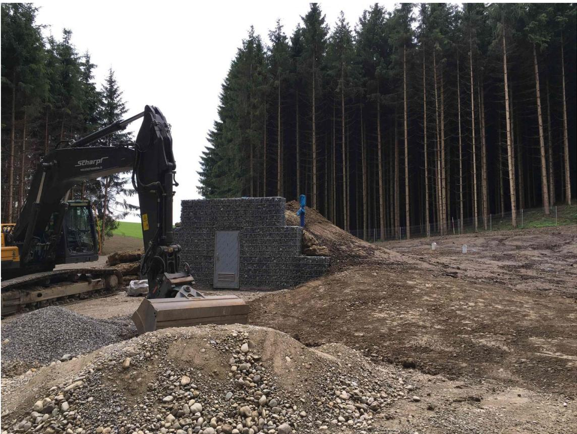
**Herstellung Zugang Quellsammelschacht**
