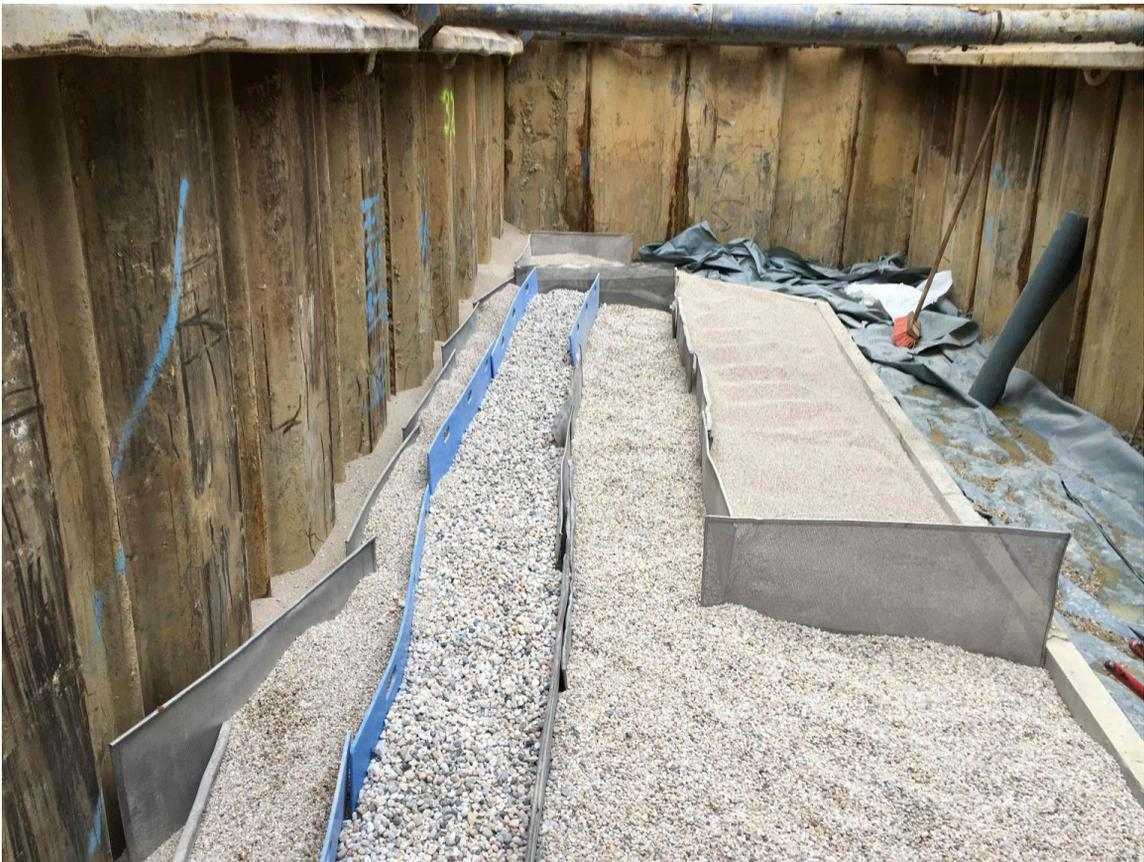
Mehrfach abgestufter Filterkies im Bereich Quelle 2
