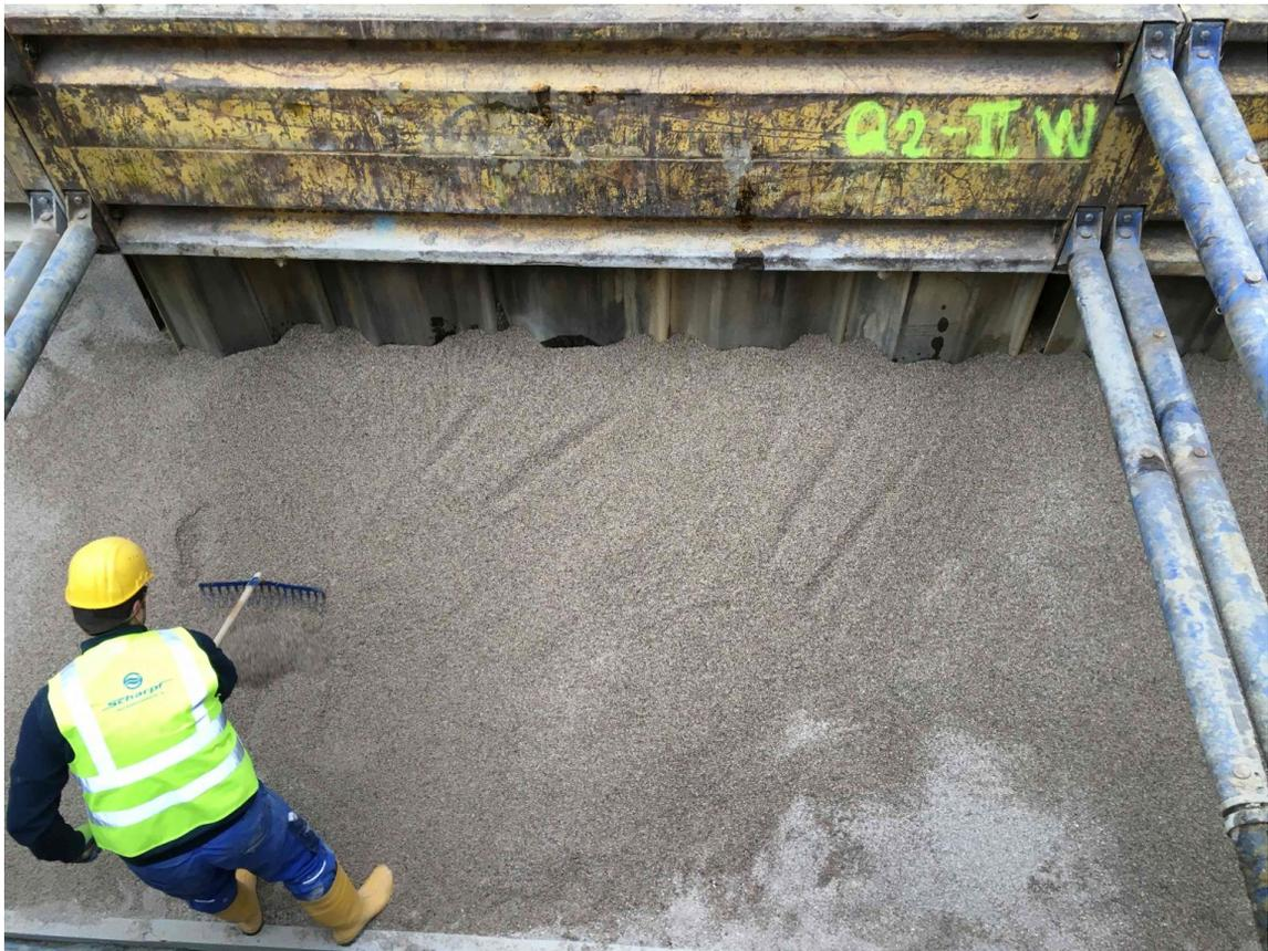
**Fertig aufgebauter Filterkieskörper Quelle 2**
