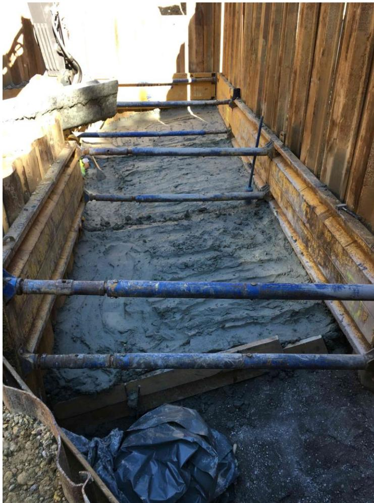
**Einbau der Tonabdichtung oberhalb der Betonabdeckung
