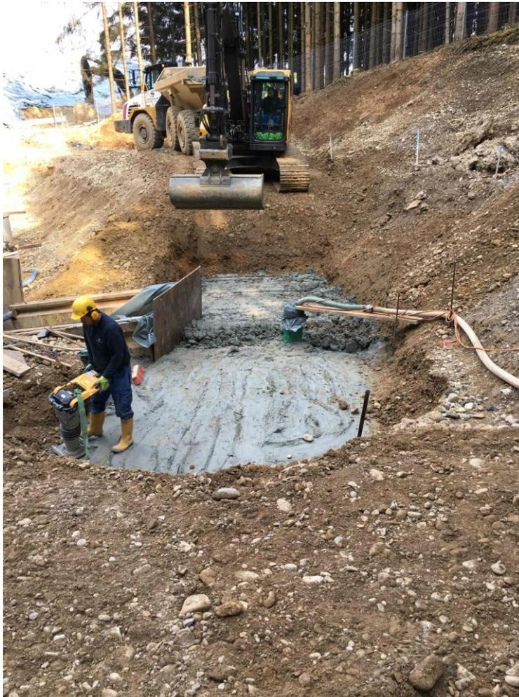
Einbau der Tonabdichtung über Quelle 2 Zulauf
