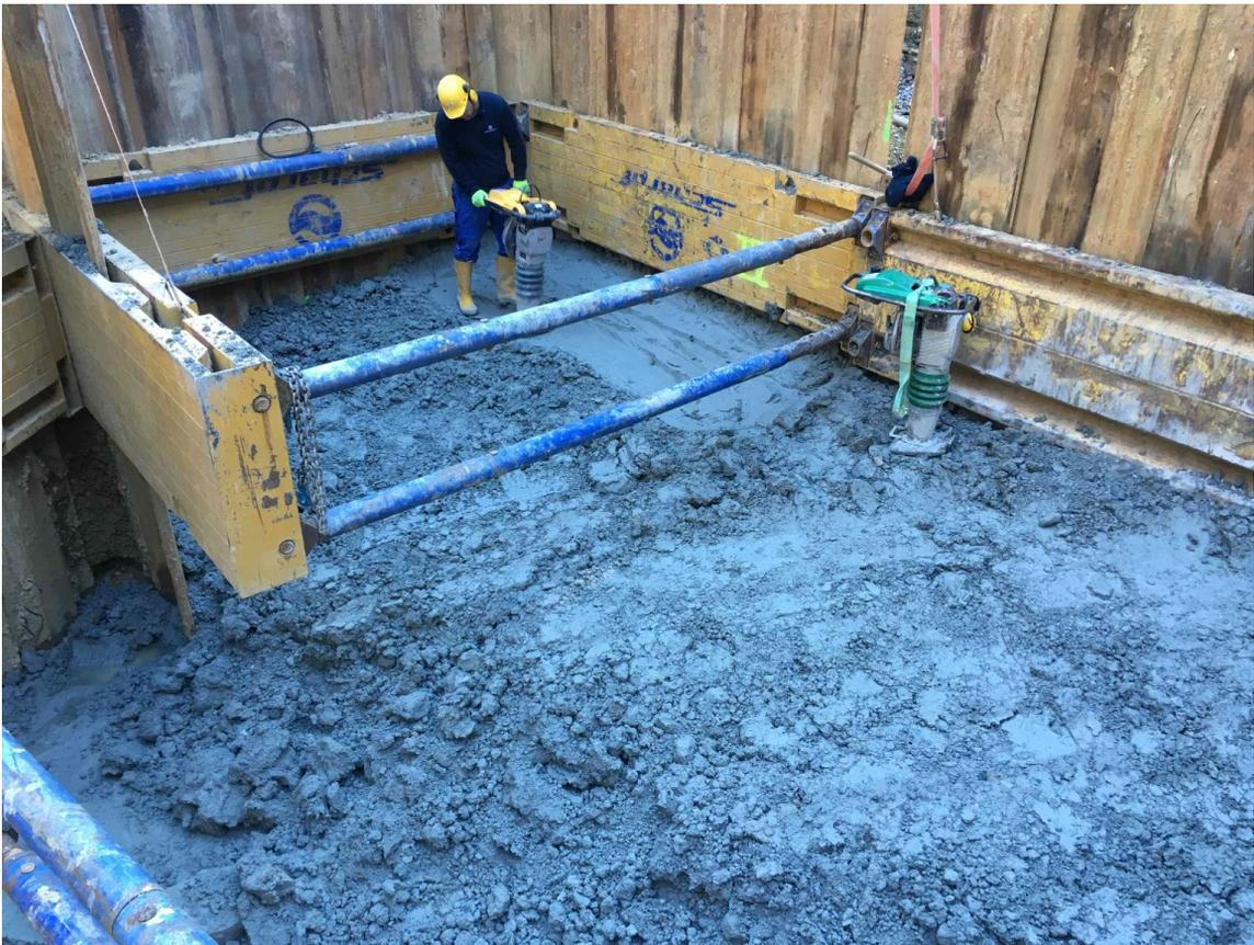
**Einbau der Tonabdichtung oberhalb der Betonabdeckung
