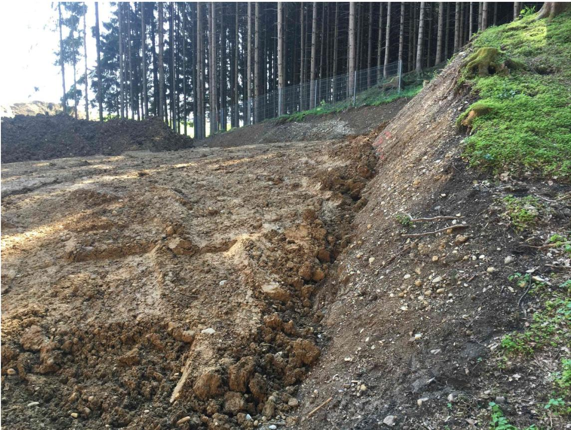
**Einbau Rotlage im Bereich Quelle 2 Zulauf**
