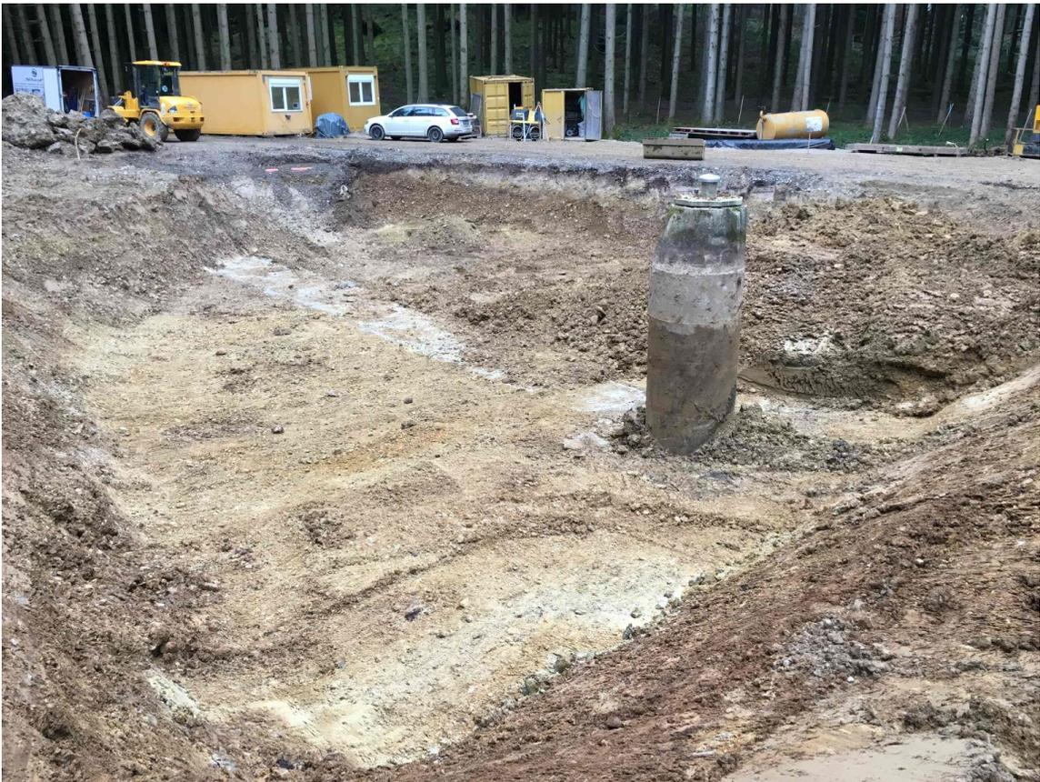
Freilegen der Betonabdeckung der alten Quellfassung
