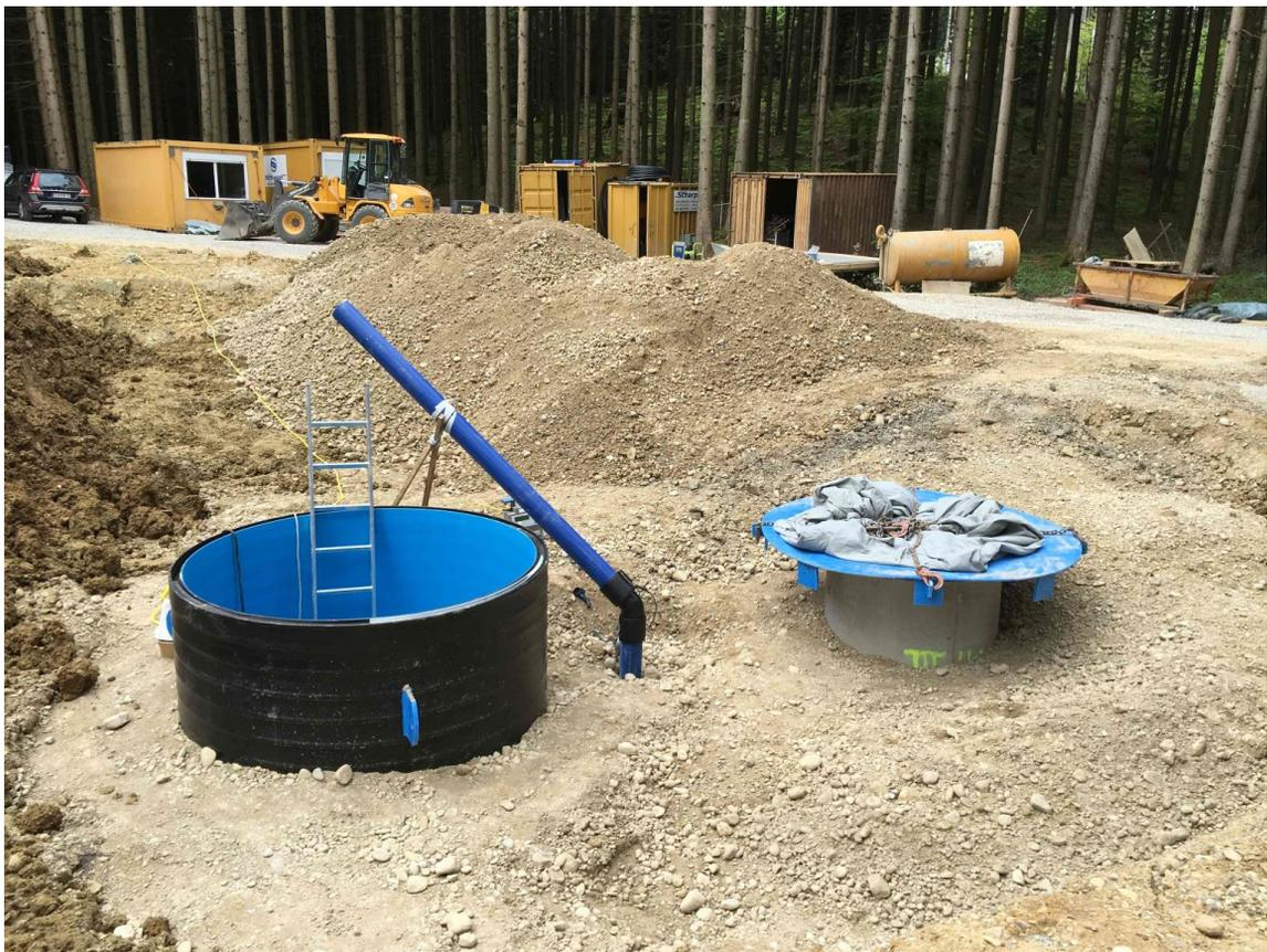
**Aufbau Zugangsturm und Belüftungsrohr**
