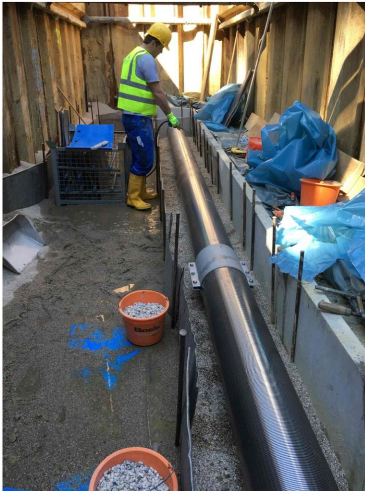
Verlegen des Wickeldrahtfilterrohres DN 300 SW 2 mm
