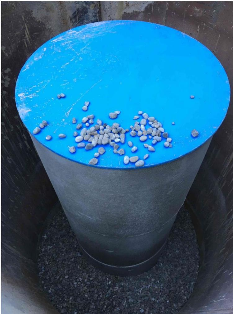
**Aufsetzen der gelochten Schachtringe DN 1000 und
