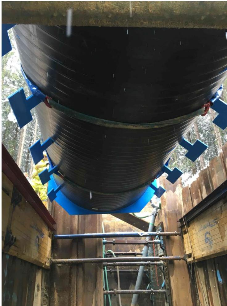
Versetzen des Quellsammelschachtes in die Baugrube
