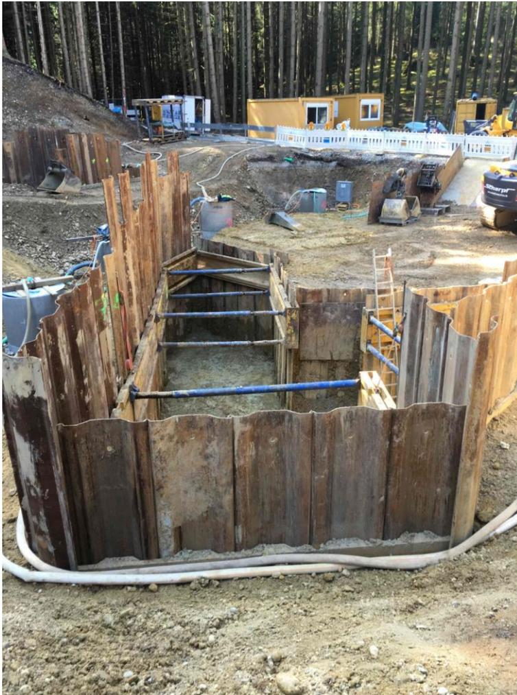
**Baugrube und Verbau Quelle 1 und Quelle 2 Zulauf im Hintergrund**
