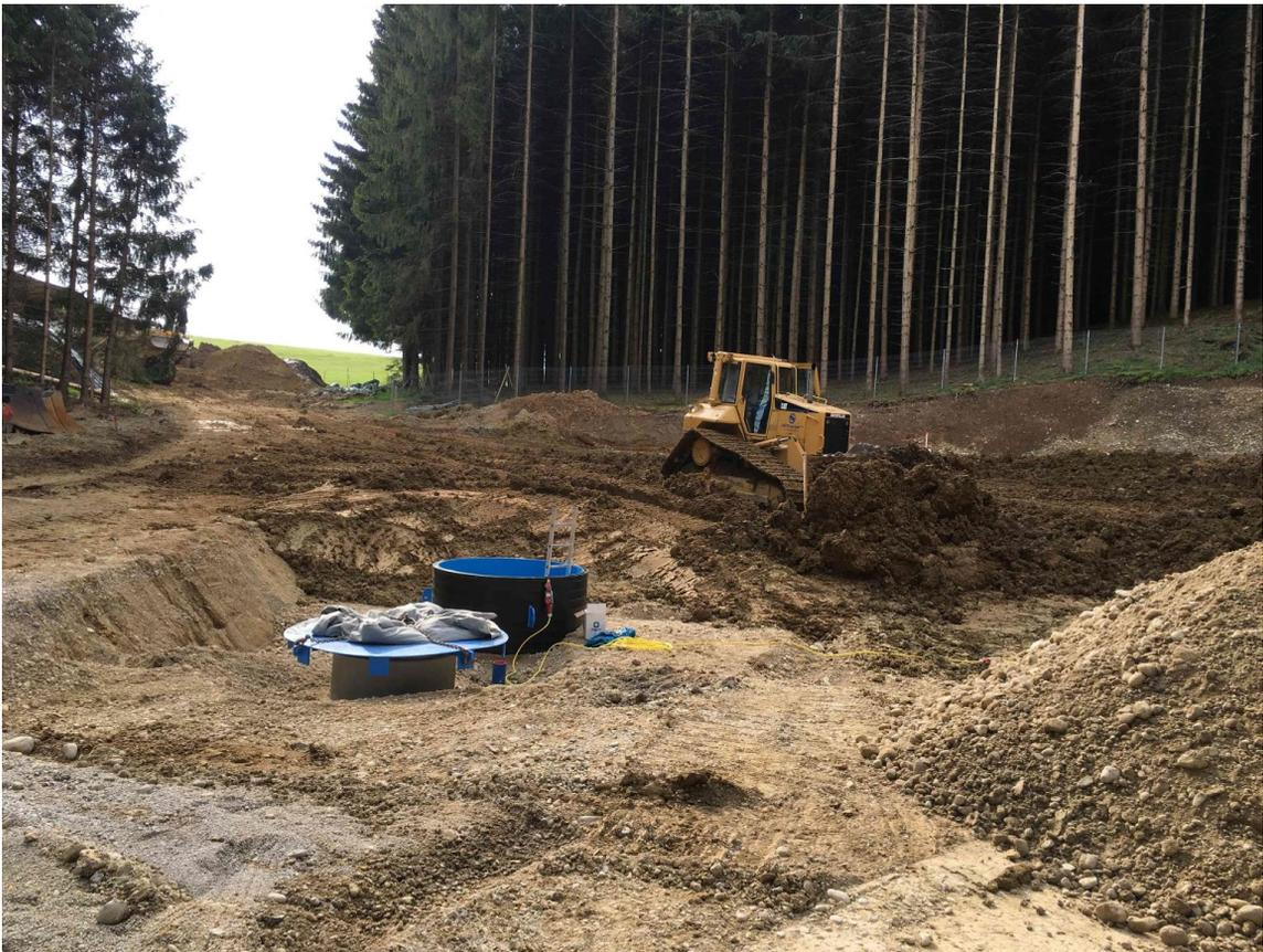
**Rückverfüllen des Geländes und Aufbau Zugangsturm
