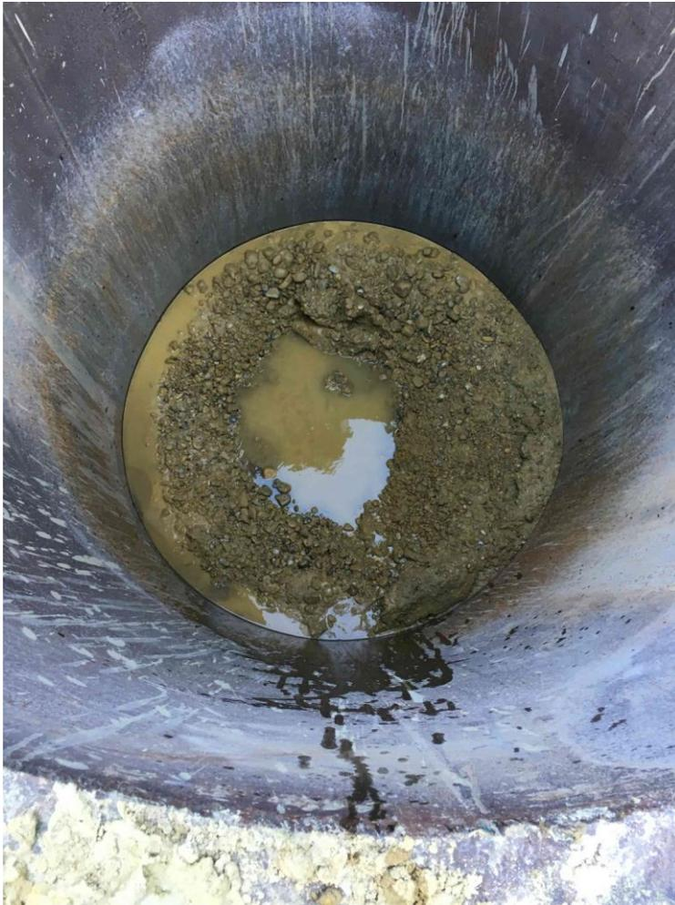
Ausheben der Baugrube mit Hilfe von einer Stahlverrohrung
