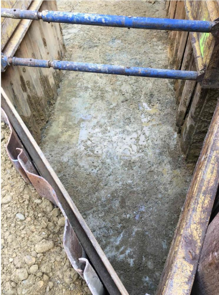
**Grundwasserstauer freigelegt für Quelle 1 vor Einbau der
