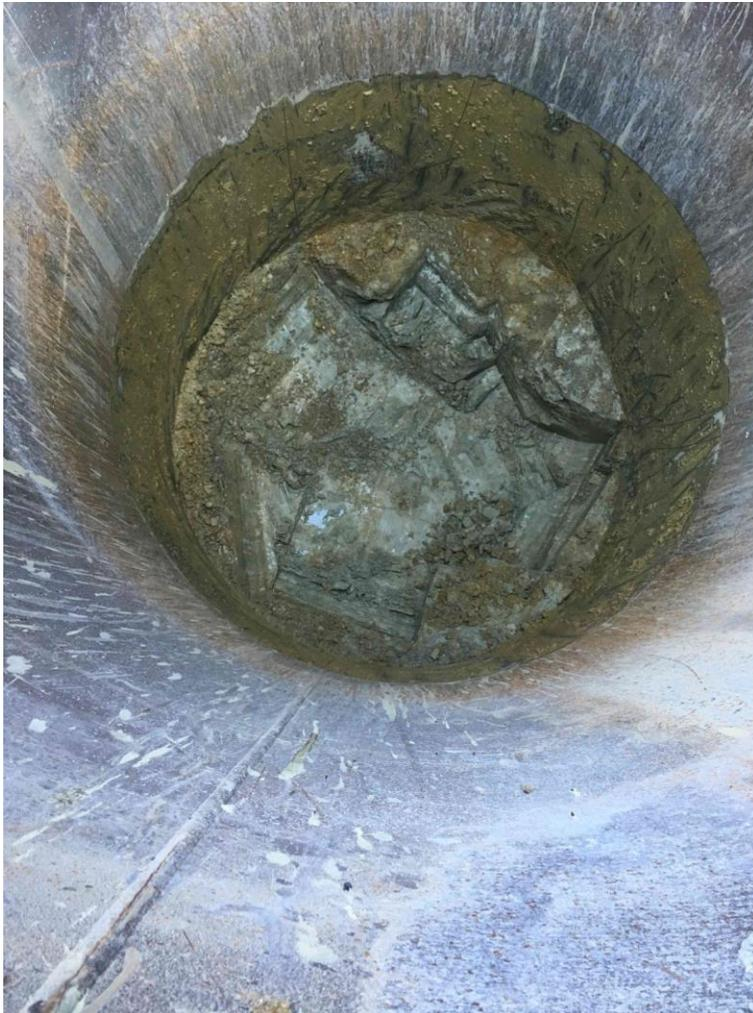
Ausgraben der Rohre bis in den Grundwasserstauer
