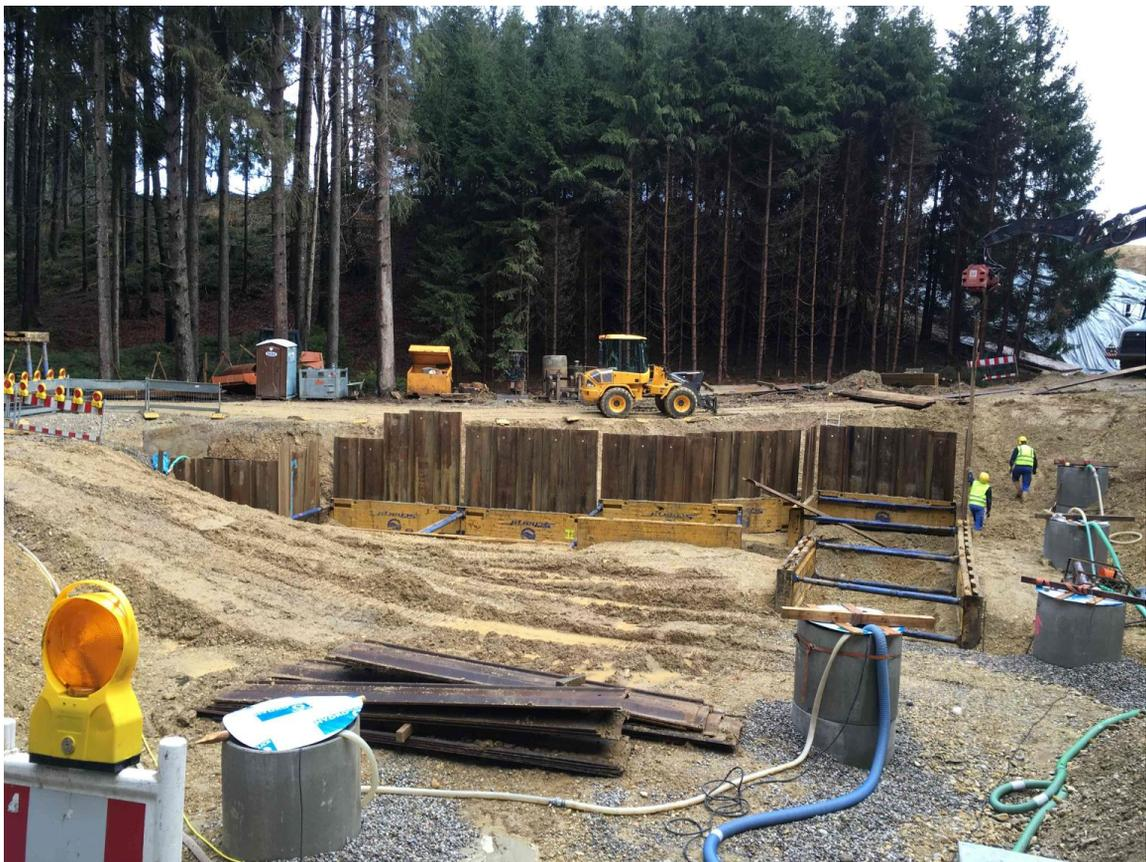
**Dielenkammerelemente mit zum Teil eingebauten
