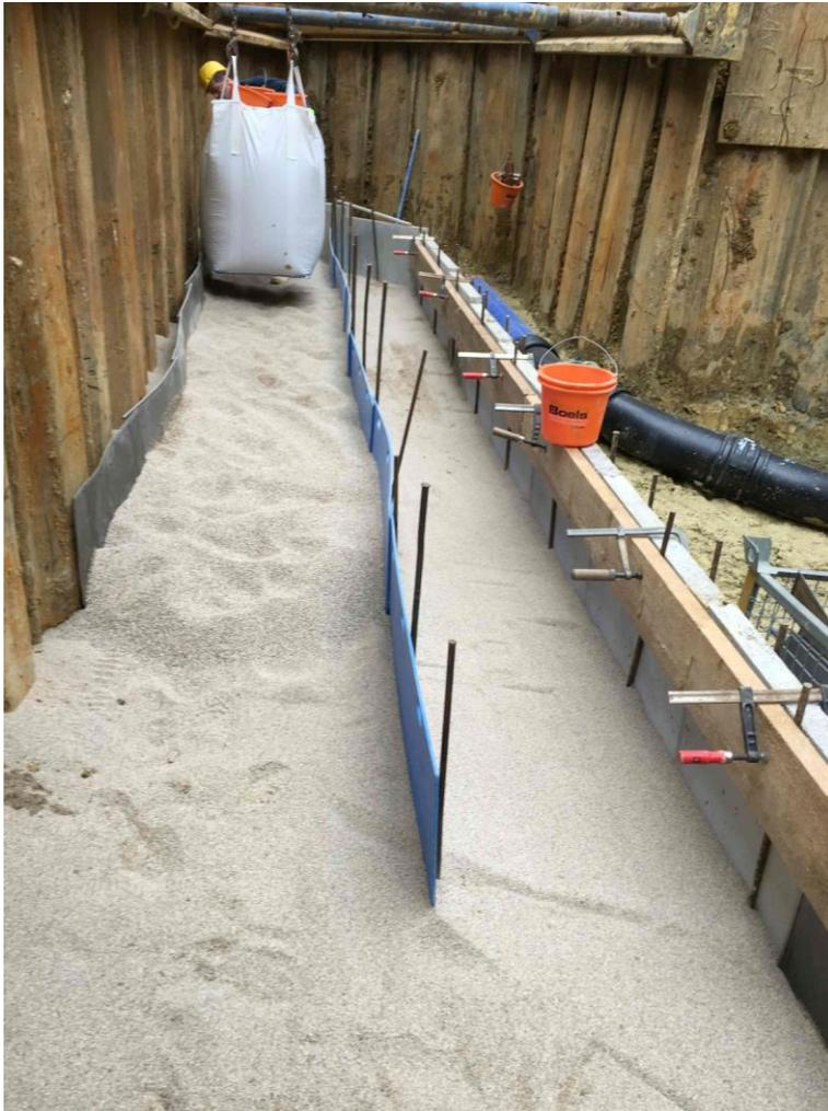
Einbau der Filterkiese in unterschiedlicher Kornabstufung
