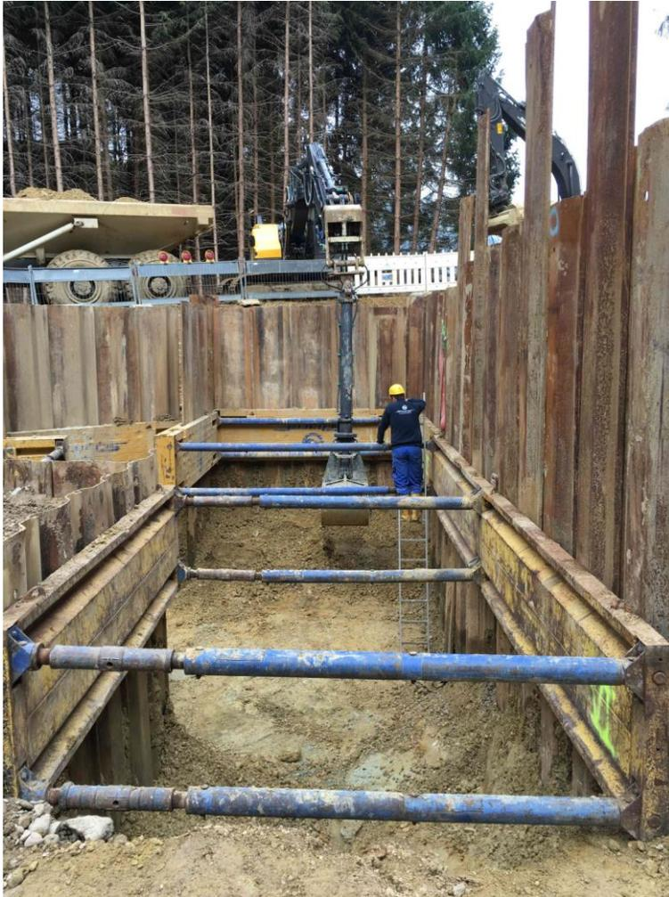
**Ausheben der Baugrube für Quelle 1 bis zum
