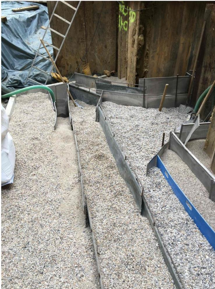
Mehrfach abgestufter Filterkies im Bereich Quelle 2 Zulauf
