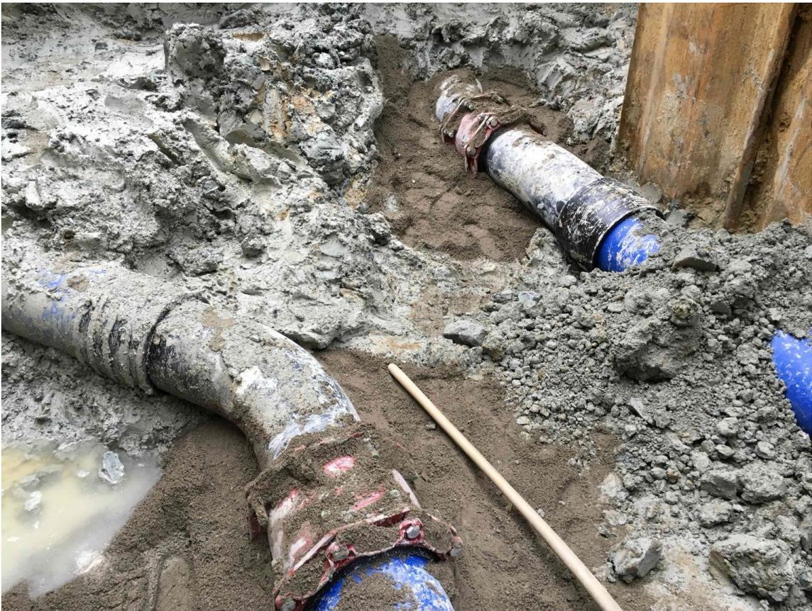
Anbinden der Quellleitungen PE 100 da 315 mm
