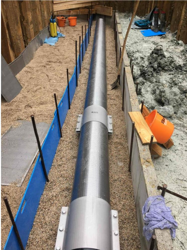
**Verlegen des Wickeldrahtfilterrohres DN 300 SW 2 mm mit
