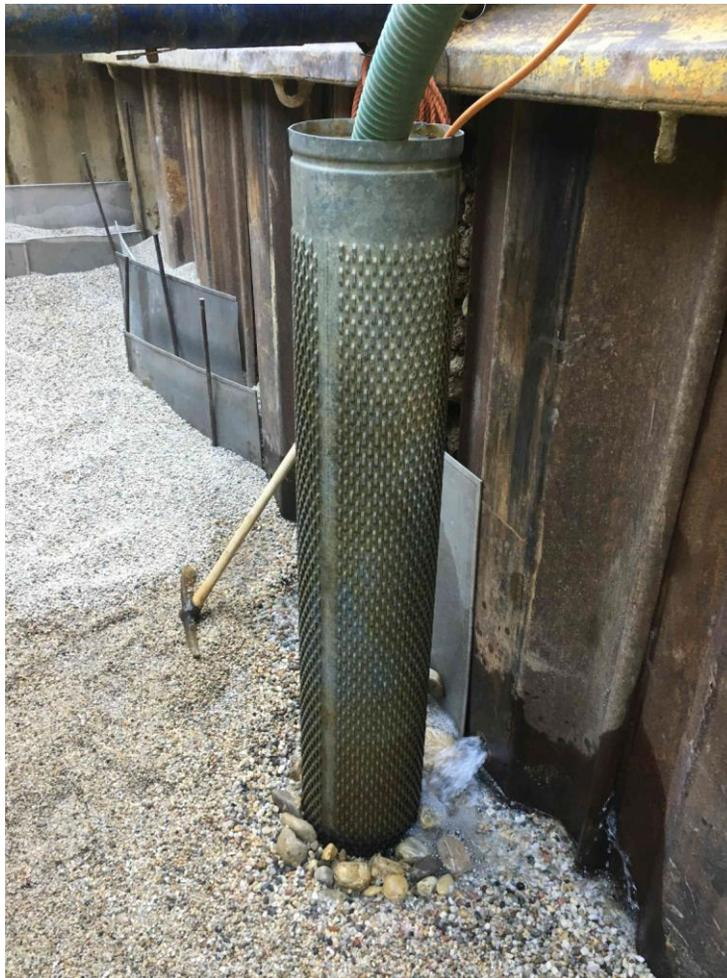
Temporärer Einbau eines Schlitzbrückenrohres DN 300 in
