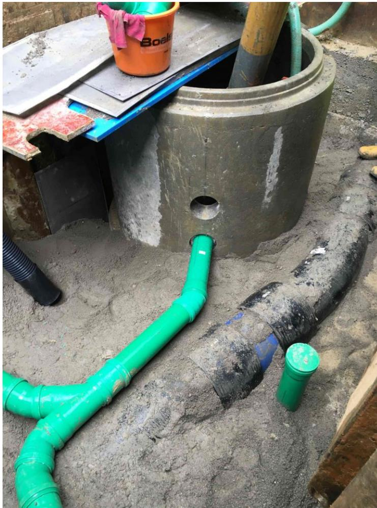
Verlegen der Drainagen an den Klappenschacht
