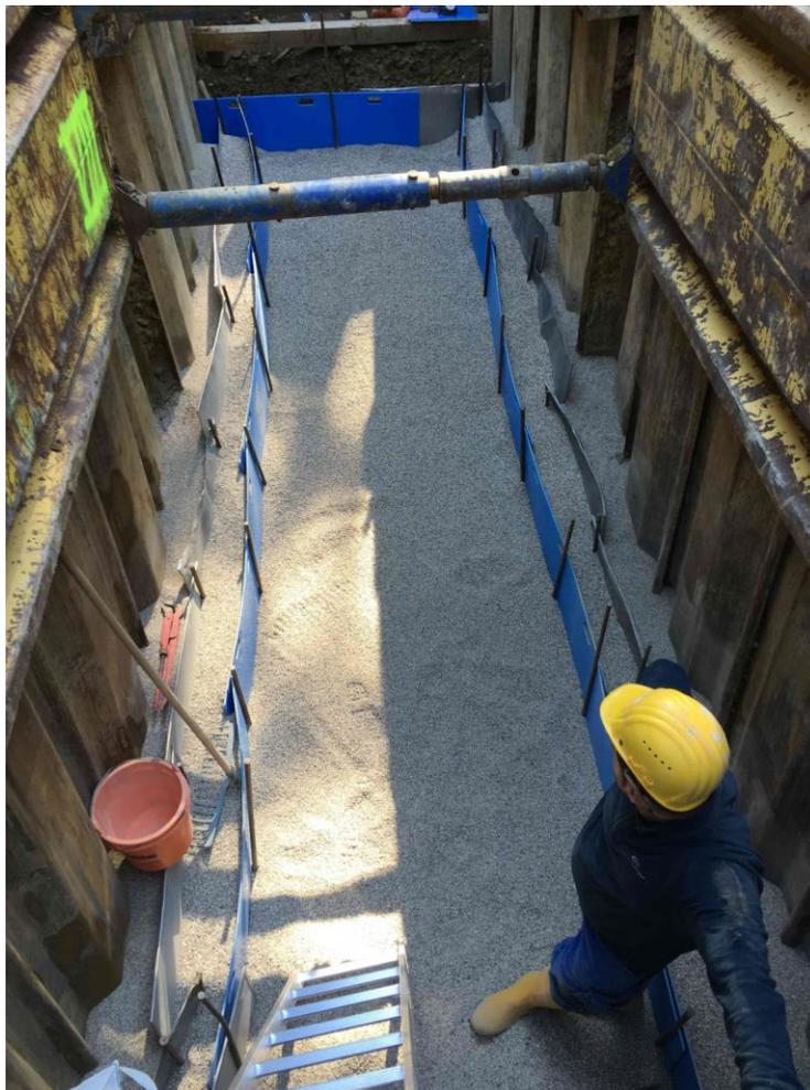
**Filterkiesaufbau Quelle 2 Zulauf**
