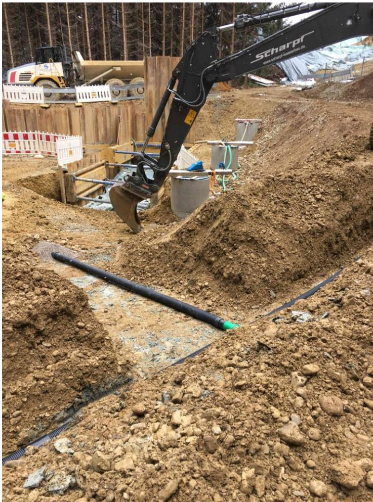
**Verlegen der Drainage über der Tonabdichtung von Quelle 2
