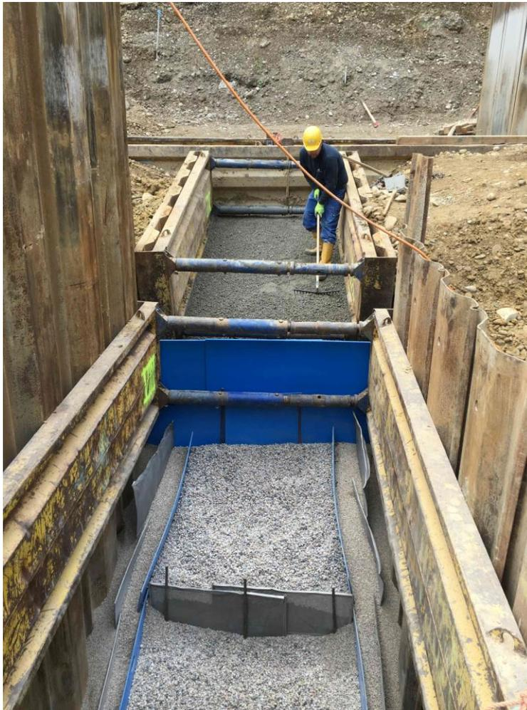
**Abschnittsweiser Einbau der Betonabdeckung der Quelle 2
