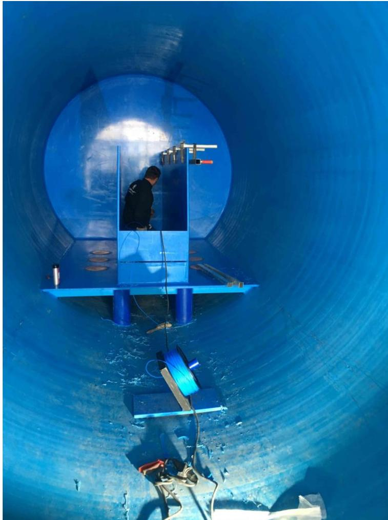
**Aufbau Trennwände Quellsammelschacht**
