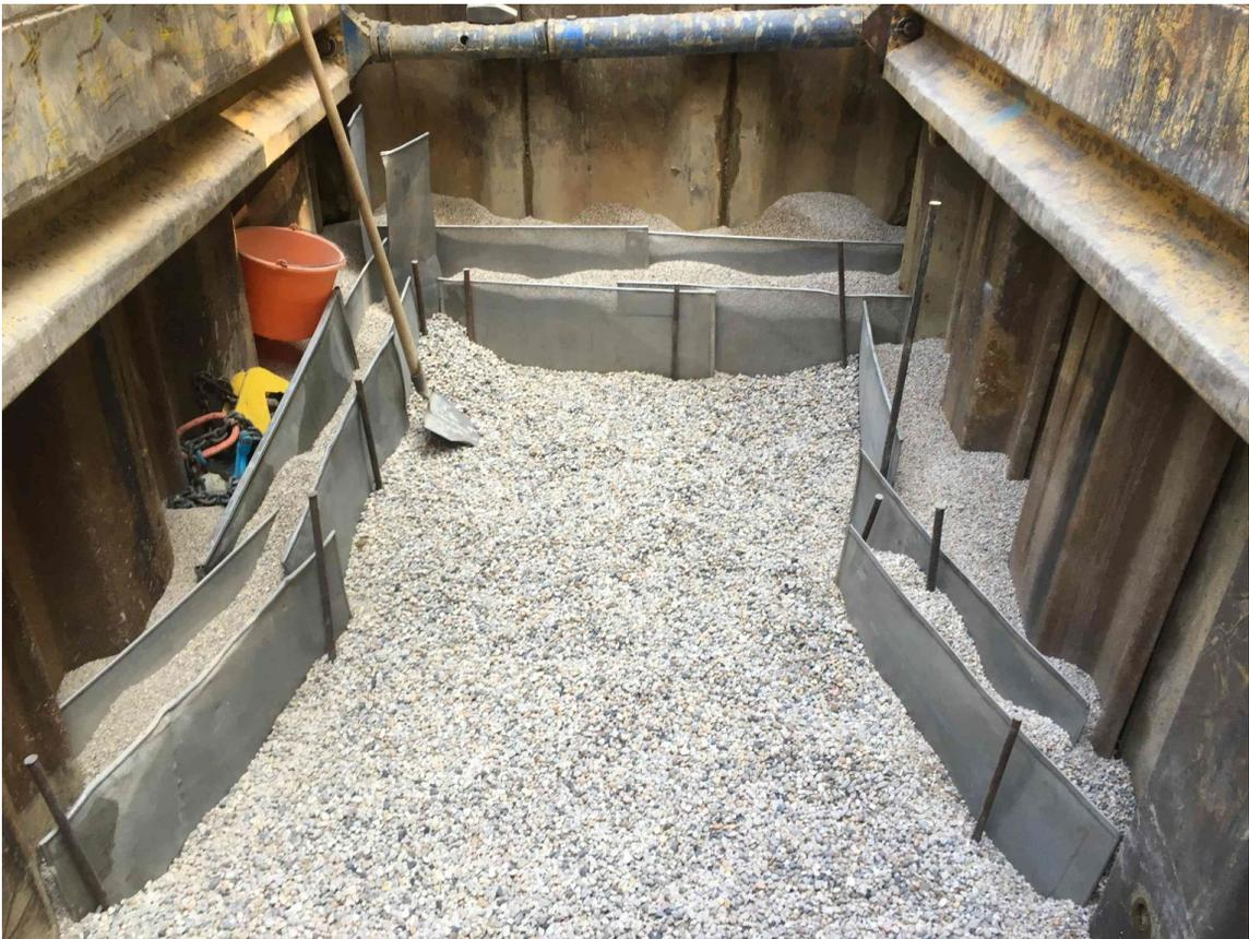
**Filterkiesaufbau Quelle 2 Zulauf**
