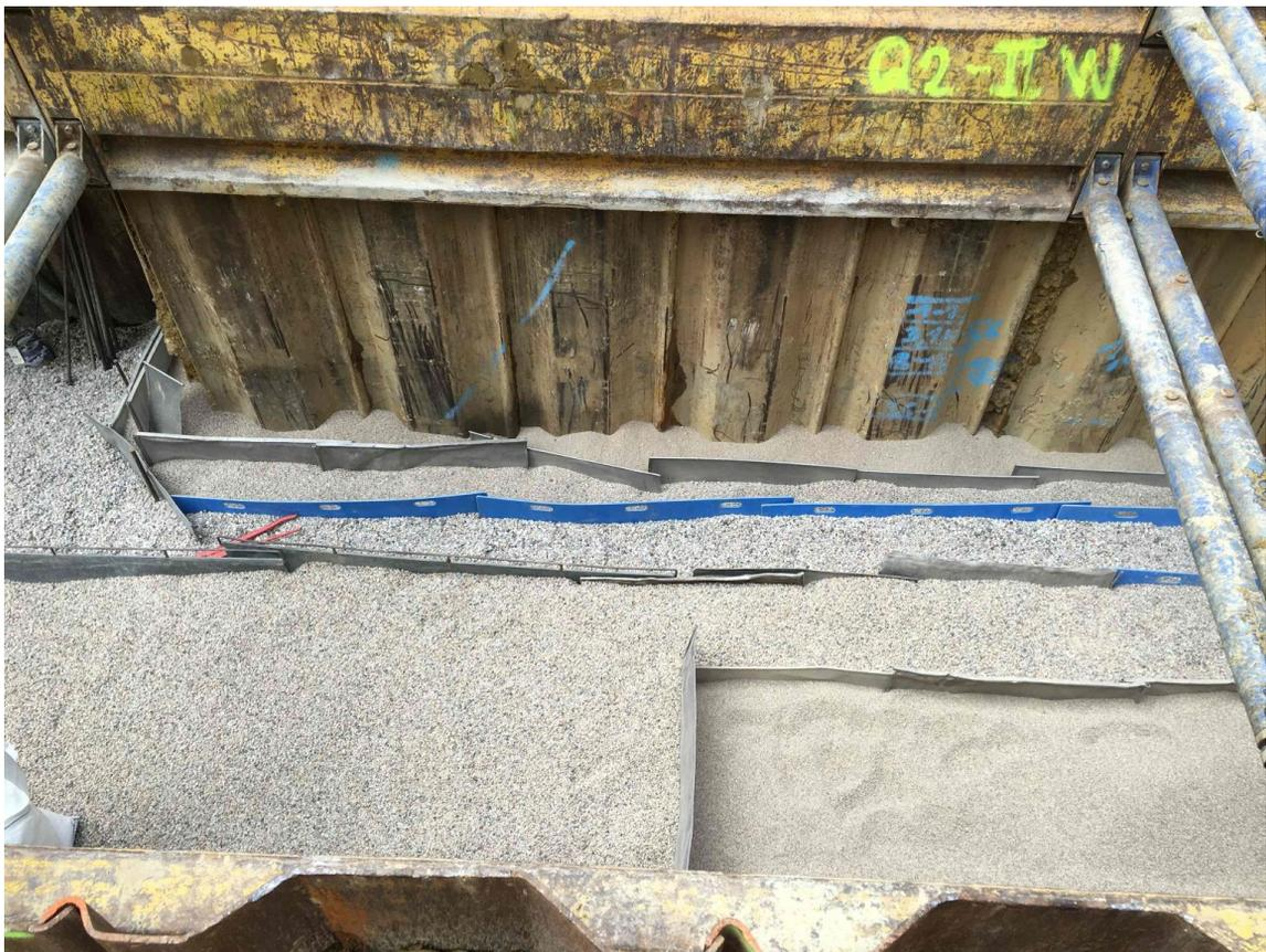
Mehrfach abgestufter Filterkies im Bereich Quelle 2
