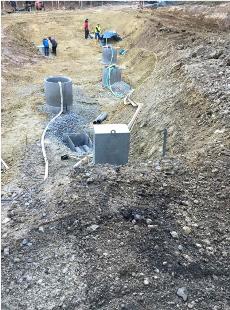
Inbetriebnahme der fünf Schachtbrunnen zum Absenken
