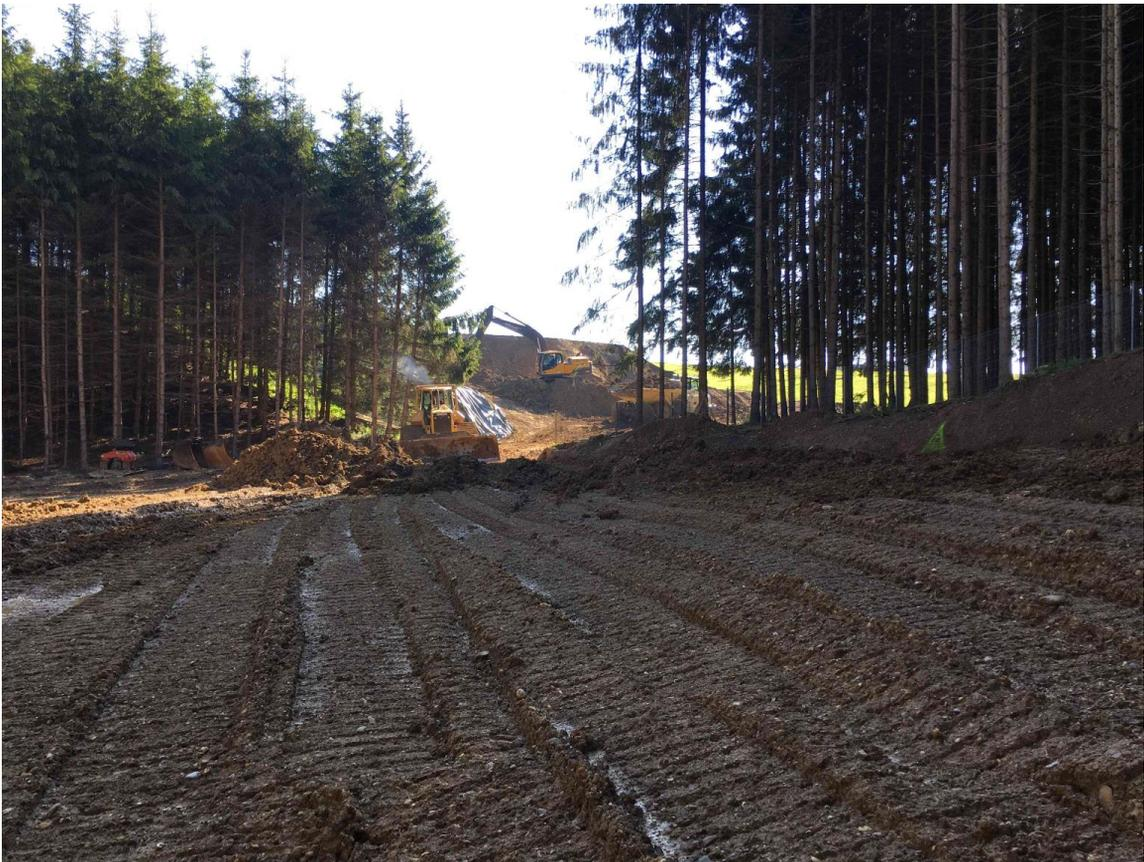
**Einbau Rotlage im Bereich Quelle 2 Zulauf**
