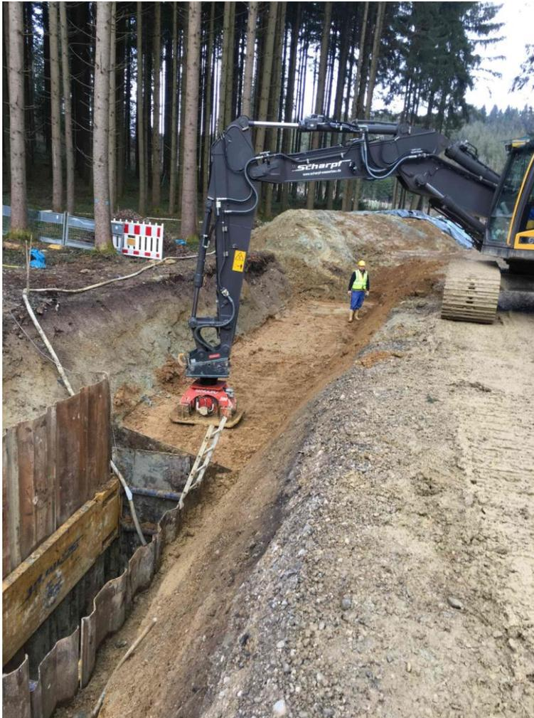
Lagenweiser Einbau von Rotlage oberhalb der
