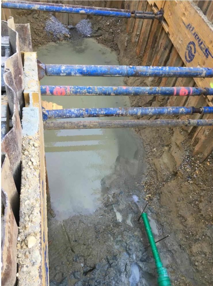
Absetzbecken im Bereich der Quellsammelschachtbaugrube
