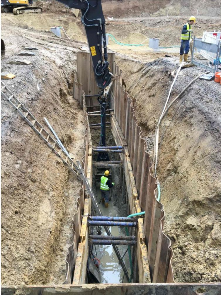
**Aushub der Rohrtrasse in tertiären Sanden bei etwa 6,5 m
