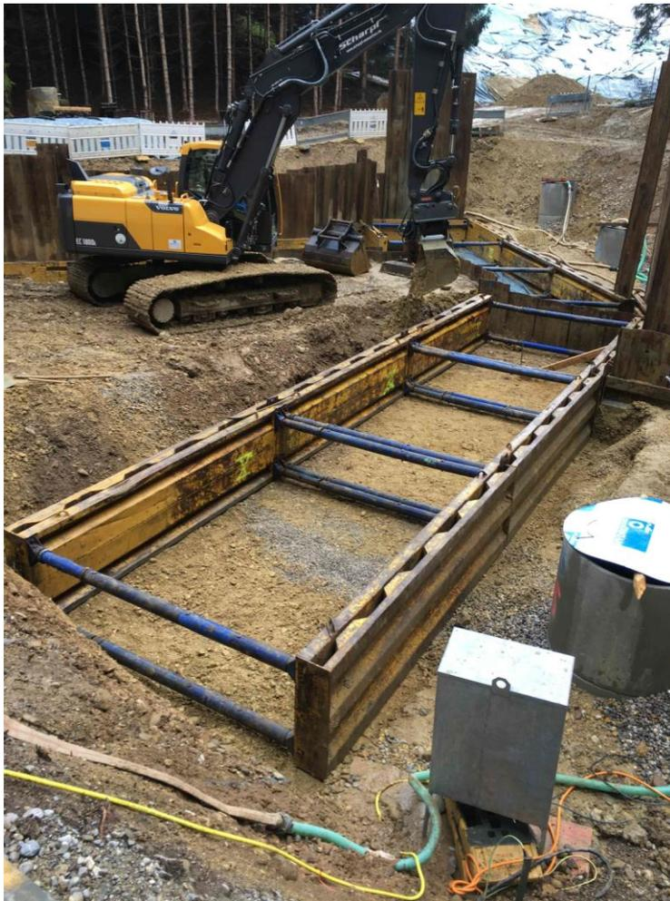
Setzen der Dielenkammererelemente zum Herstellen der
